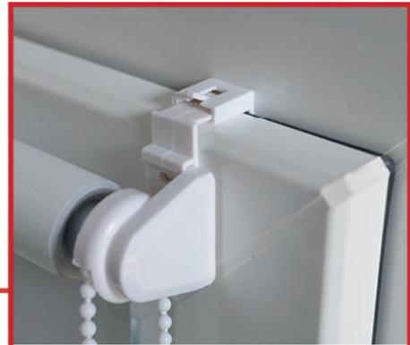
Klemmträger mit Träger und Kettengetriebe zusammengebaut
